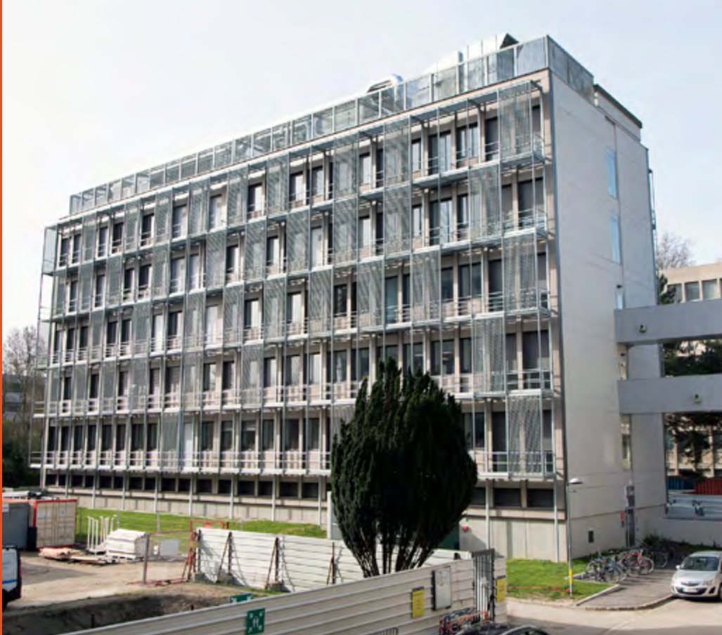
Bâtiment Dubois rénové (Campus LyonTech - la Doua)
